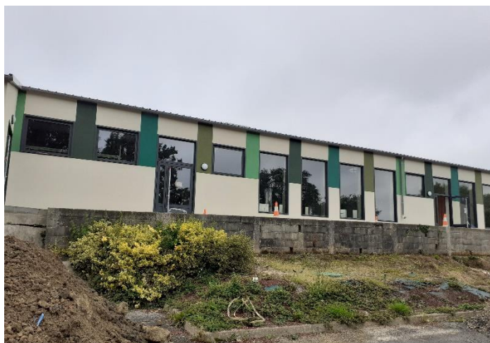
Façade arrière côté parking
