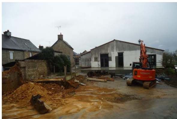
Démolition du garage situé à l'entrée
